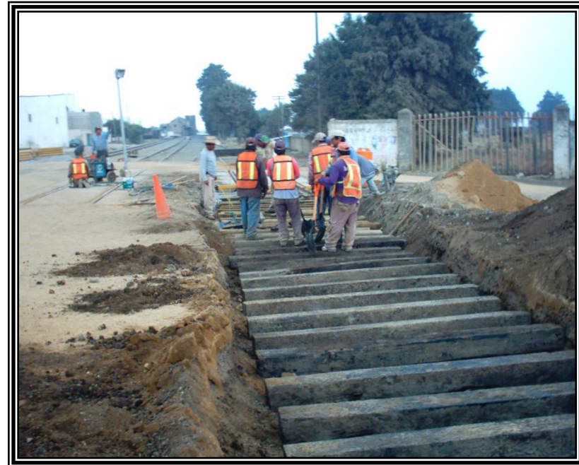
COLOCACIÓN DE DURMIENTES NUEVO DE MADERA DE 7" X 9" X 9', ESPACIAMIENTO
