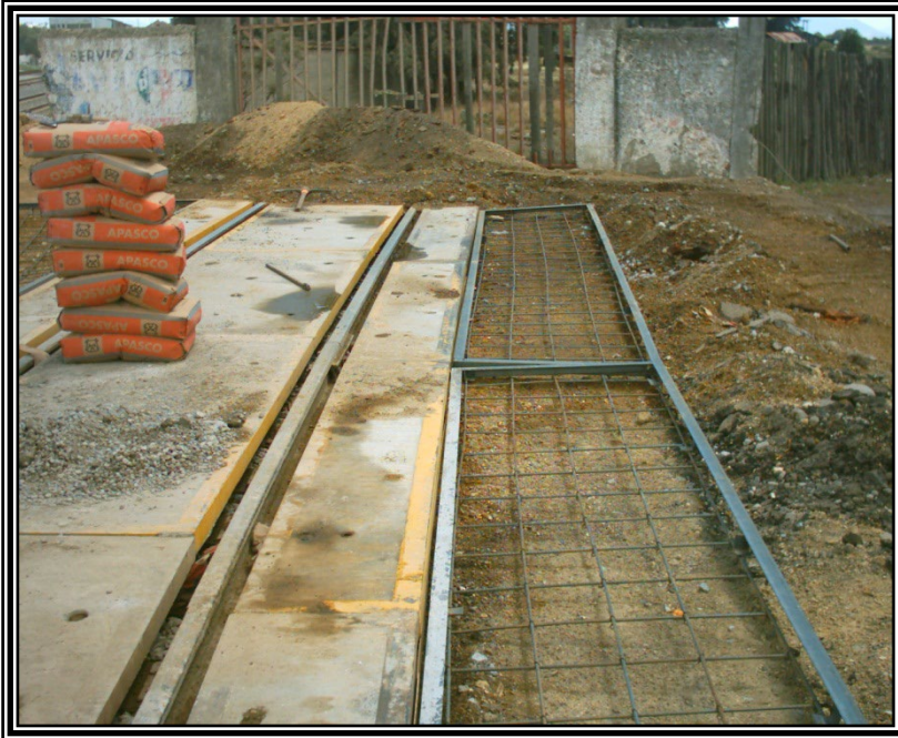
HABILITADO DE REFUERZO PARA SUPERFICIE DE RODAMIENTO.
