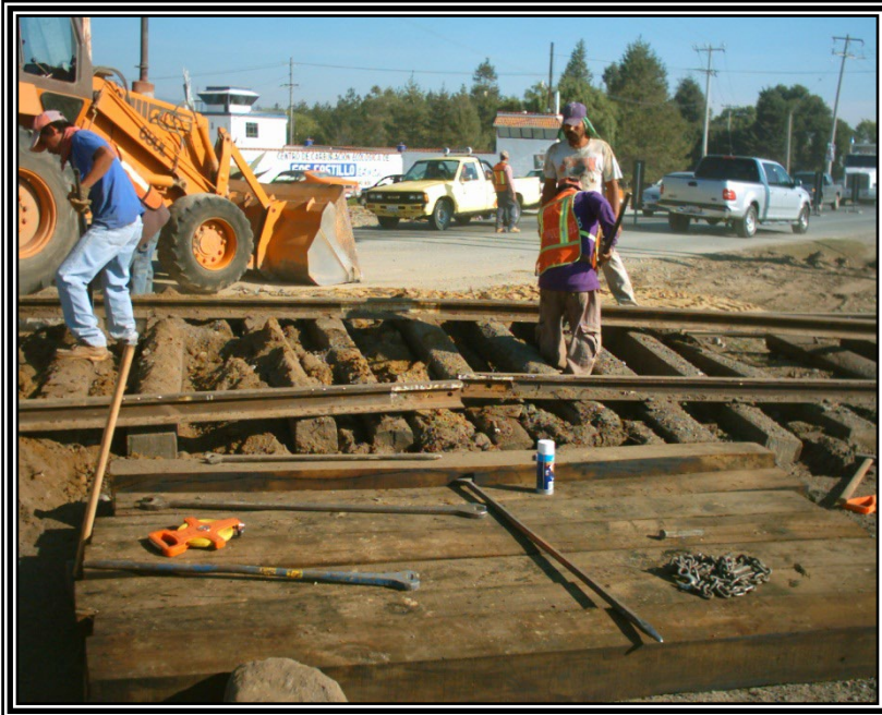
COLOCACIÓN DE DURMIENTES NUEVO DE MADERA DE 7" X 9" X 9', ESPACIAMIENTO
